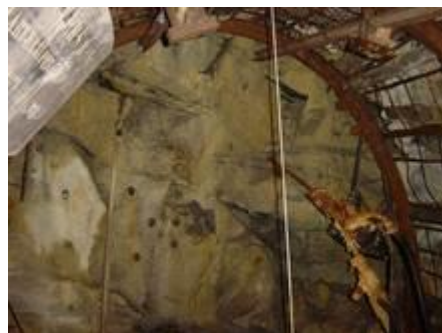
Sprenglöcher bohren
