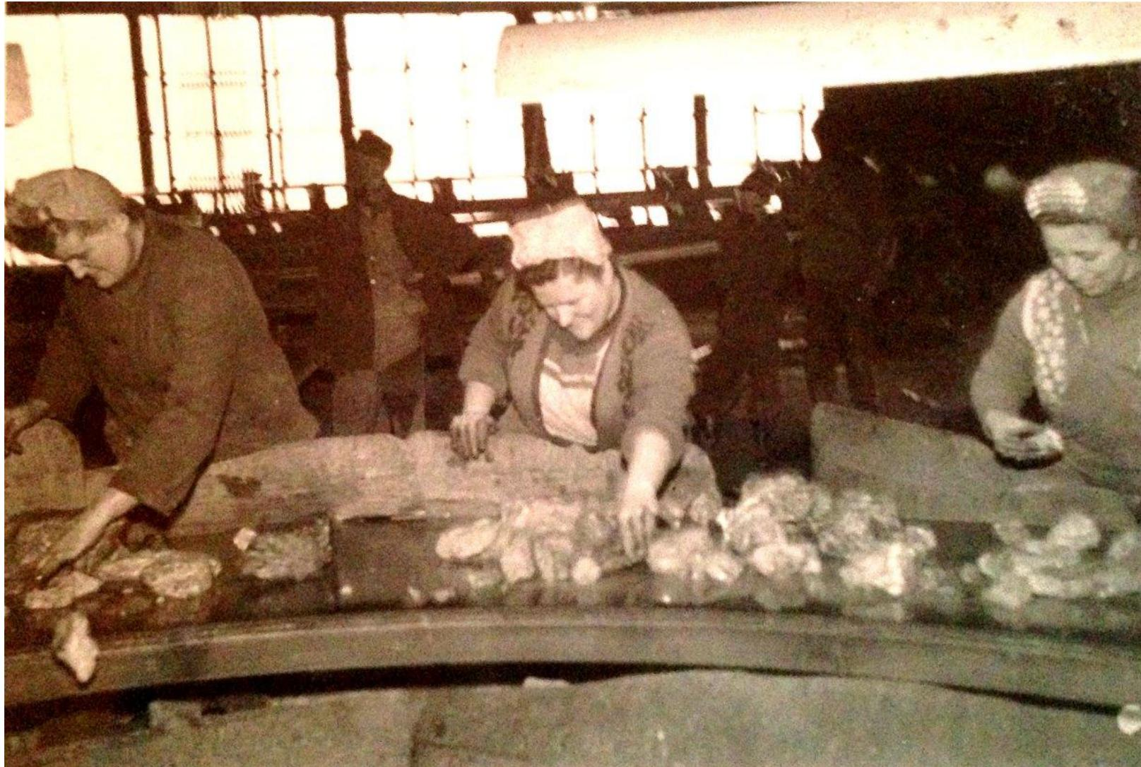
Neben den „Erzengel“ standen Kisten in die das Buntmetall (Kupfer, Kupferkies, Blei,...) geworfen wurde. Das erzhaltige Gestein wurde am Ende der Lesebank abgestreift und fiel in den Erzbunker. Von hier aus ging es mit Kippwagen zu den Röstöfen. Über einen Aufzug wurden sie mit Eisenstein und Koks beschickt. Durch das Erhitzen in den Röstöfen konnten schädliche Bestandteile für die Verhüttung, wie z.B. Schwefel, verbrannt
