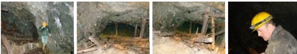
Auf diesem Podest muss das Lokomobil zur Druckluftzeugung (Bohren) gestanden haben. Das Gesenk und Gesenksohlen stehen unter Wasser.
