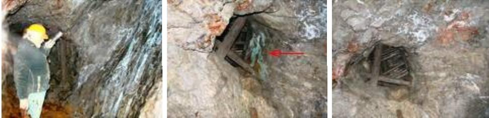
Hier wurde ein Überbau geschlagen um einem Erzgang zu folgen. Deutlich zu sehen ist eine seitliche Kupferkluft (Fläche). Dem Erzgang folgend entstanden mehrere Arbeitsbühnen die über Fahrten erreichbar waren. Einen solch guten Erhaltungszustand sieht man selten.
