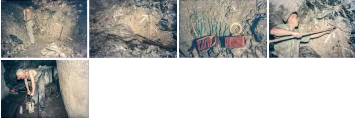
Vor Ort - Bohrlöcher - Schiessmaterial (Patronen) - Bohrloch besetzen - Sprengen
