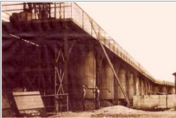
Während die ersten Röstöfen „in den Hang hinein“ gebaut wurden sind spätere Anlagen aus Eisen in direkter Nähe zum Förderschacht errichtet worden. Diese Bild der Röstofenanlage ist von der Grube Bautenberg bei Wilden.
