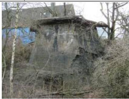
**Rösten von Eisenerz:** Nachdem der Spateisenstein zu Tage gefördert war wurde er in Brecheranlagen gebrochen. Das taube Gestein wurde per Hand ausgelesen oder durch Maschinen entfernt. Danach kam das Erz in einen Röstöfen. Hier wurde bei großer Hitze z.B. Wasser und Schwefel ausgeschieden. Durch das Rösten wurde der Spateisenstein in Eisenoxid umgewandelt. Dies
